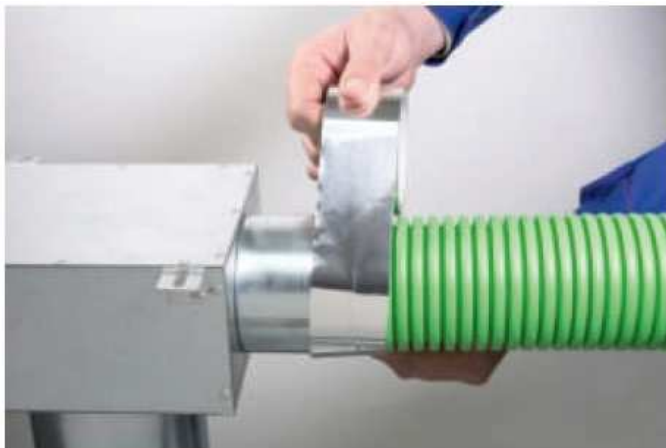
7) A csatlakozást légmentes ragasztószalaggal biztosítjuk.
