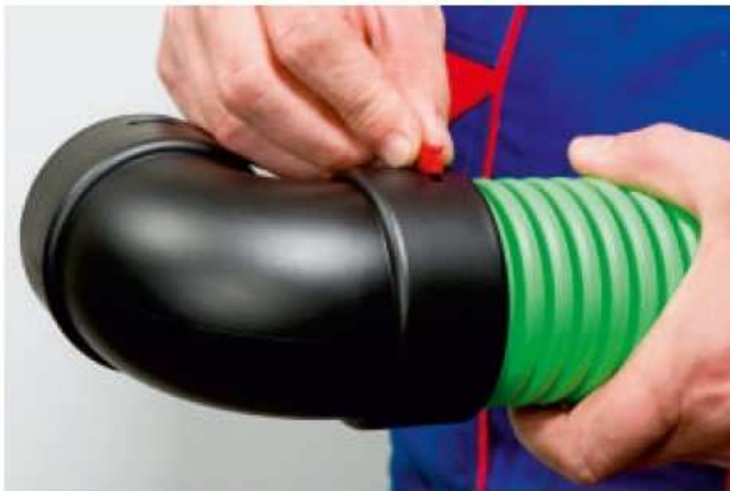
7) A biztosító saruk nyílásait a cső belsejéig viszonyítva a középhezetre illeszteni, majd mindkét biztosító sarut a maximális mélységbe betolni kell.
