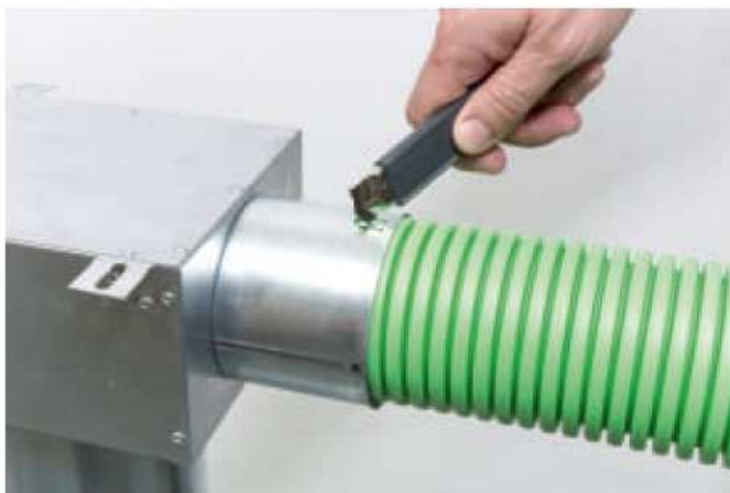
5) Benyomjuk mindkét biztosítékot, a csövek kitolódása ellen.
