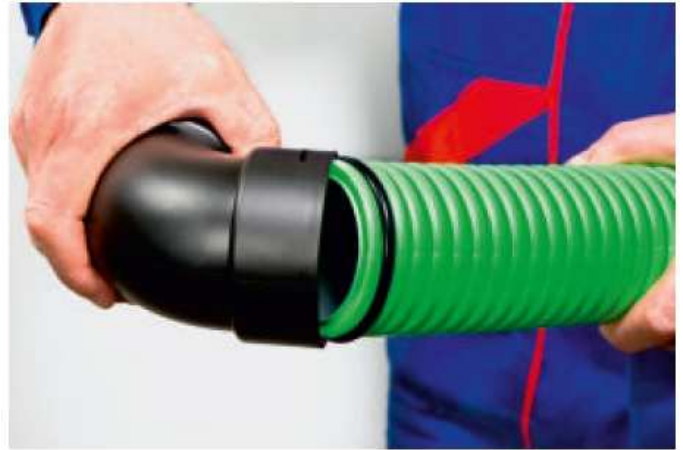
6) A könyökrészt a maximális hajlásszöge alatt helyezzük fel a csőre, majd a cső enyhe elfordítása útján toljuk be a csőbe.
