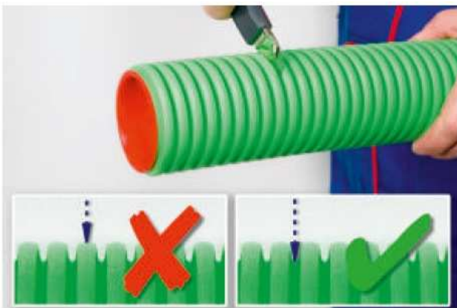
1) A csövet a korrugált alj részében a megfelelő méretre kell lerövidíteni.
