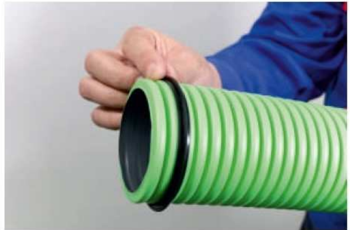
2) A tömítőgyűrűt a 2. vagy a 3. barázdába telepítjük.
